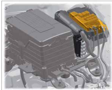
Elektrikbox im Motorraum links, neben der Batterie
